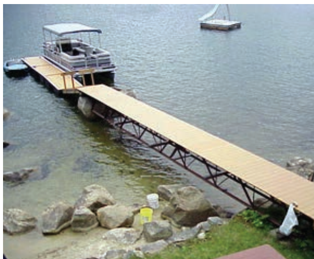
Figura 2 - Deque e píer com elementos de plástico reciclado - Plastic Lumber Yard/EUA (PARENTE, 2008).
